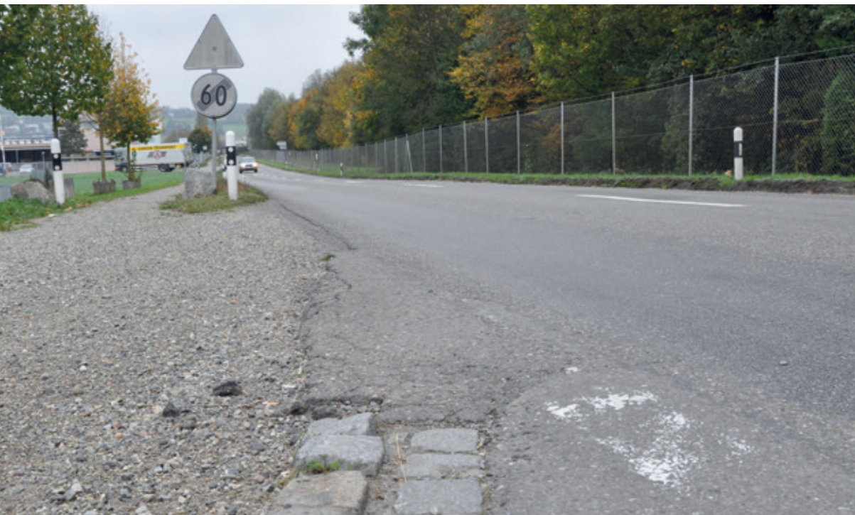
Die Anglikerstrasse muss dringend saniert werden. Vorgesehen ist nebst einem Rad- und Gehweg auch der Bau eines Kreisels auf der Höhe des «Coop Bau + Hobby».
